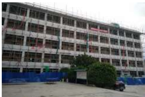
正在建设的学生宿舍
