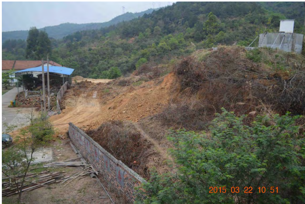
田径运动场施工前期
