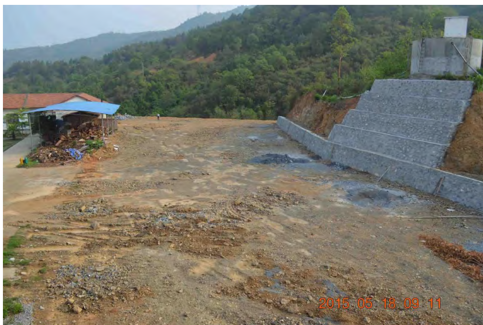
图为：2015 年 4 月底已经挖方、填土、平整好的田径运动场
